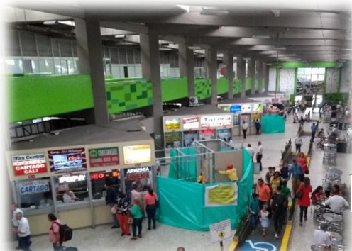
Reforzamiento estructural columnas eje central
