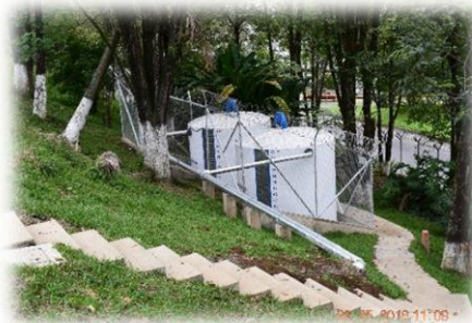
Tanques de aguas lluvias
